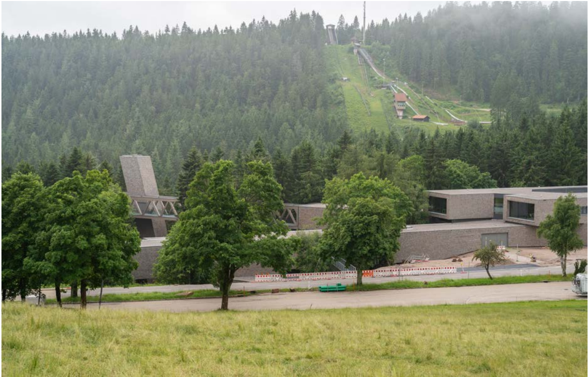
Abbildung 1: Das neue Nationalparkzentrum Ruhestein im Bau, Foto: © Daniel Müller (Nationalpark Schwarzwald)
